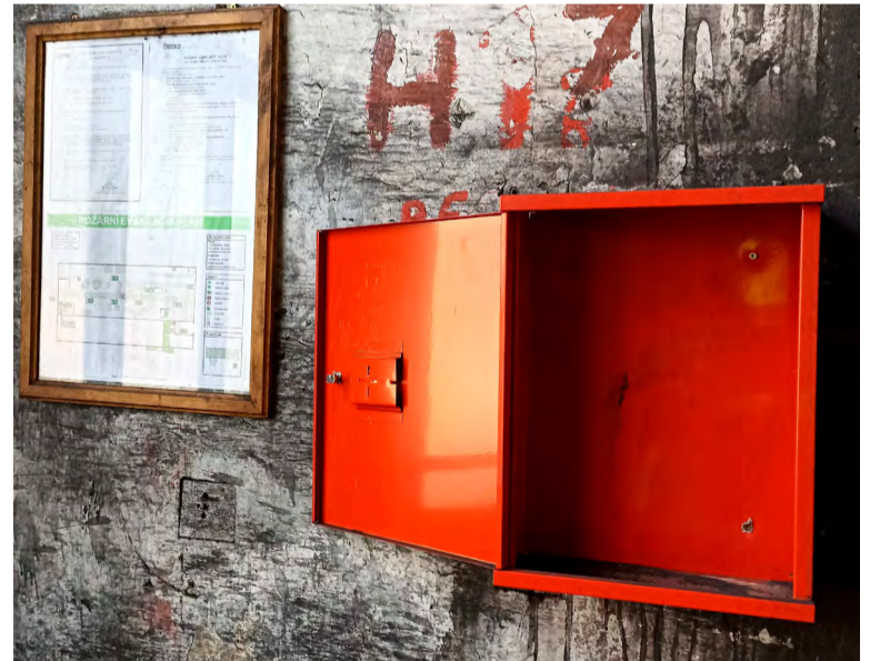
Příklady špatné praxe! Protipožární zařízení je pro snížení rizika požáru nutno udržovat v naprostém pořádku.
